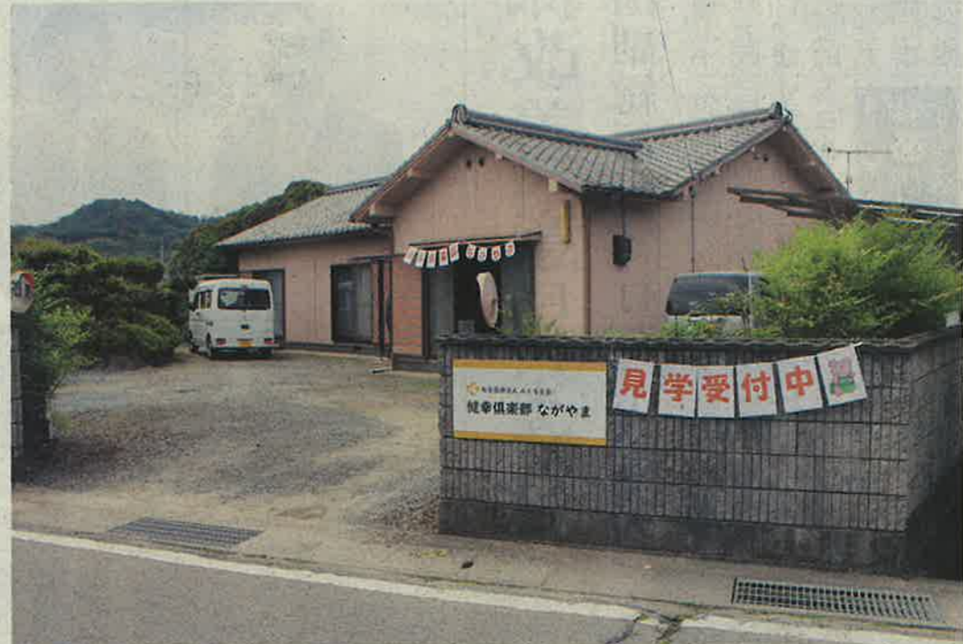
築40年ほどの民家を改修
